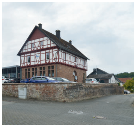
Die alte Schule ist heute das Gemeindehaus und steht den Oberbettinger Bürgern und den Vereinen offen. Auch der Gemeinderat tagt hier regelmäßig.
